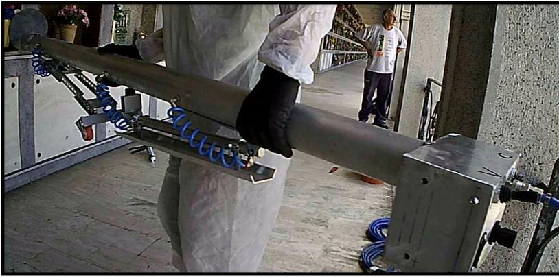
Macchinario per la chiusura dei fori presenti sul fondo dei loculi, mediante la posa di tappi in fibrocemento.
